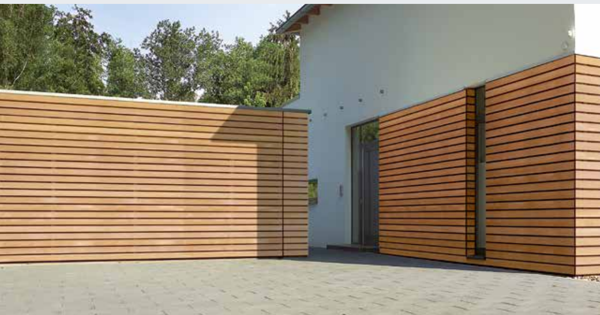
Poszycie z paneli drewnianych wykonane przez inwestora
