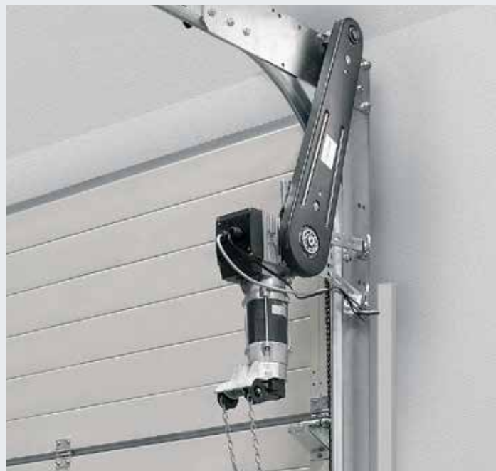
Standardowy wariant montażowy pionowy. Na zdjęciu z opcjonalnym awaryjnym łańcuchem ręcznym.
